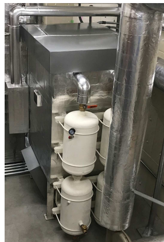
⑥ バグフィルター ボイラーの排気ガス中から粉じんを取り除く
