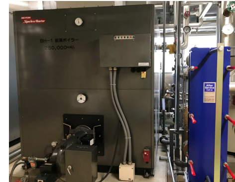
⑤ 既設の灯油ボイラー (左) 灯油ボイラーの使用を抑えることで、灯油の節約につながる
