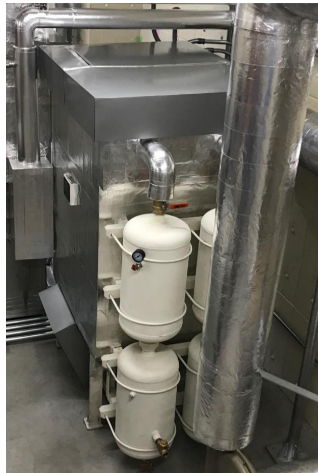
⑤ バグフィルター ボイラーの排気ガス中から粉じんを取り除く
