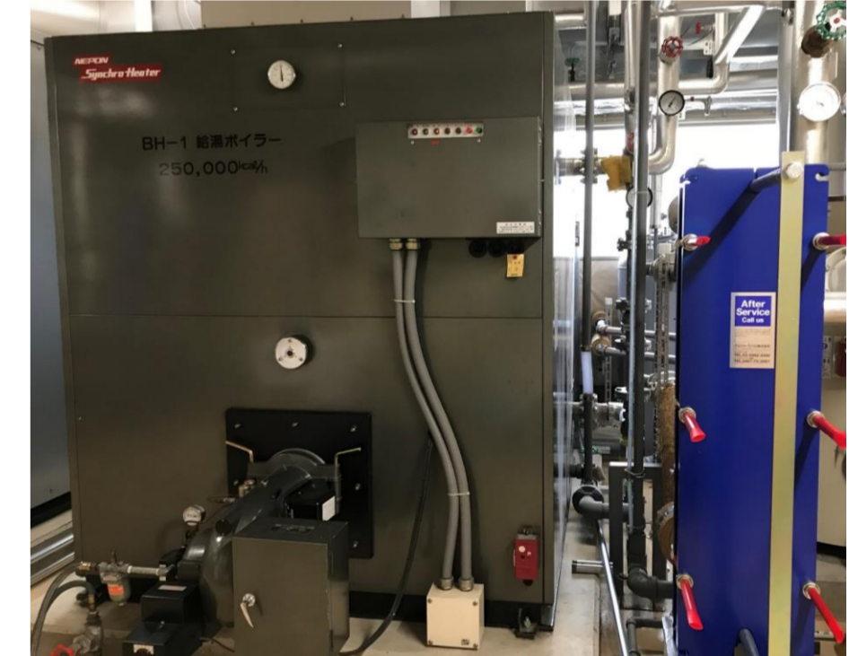
⑧ 既設の灯油ボイラー (左) 灯油ボイラーの使用を抑えることで、灯油の節約につながる
