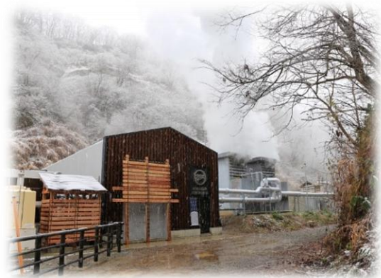
松之山温泉地熱バイナリー発電所
