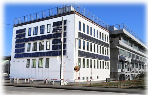
太陽光発電設備（市役所本庁舎）
