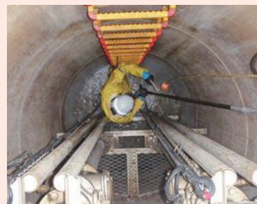
下水道管の点検もしっかりと
