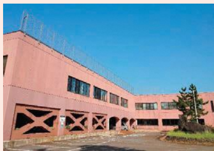
下水処理センター外観 (供用開始から42年が経過)
