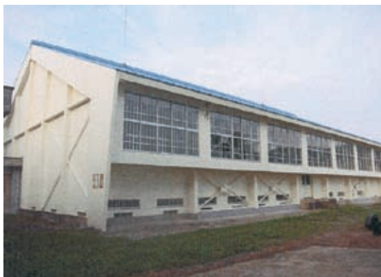
21年度に耐震化を行った東小学校体育館
