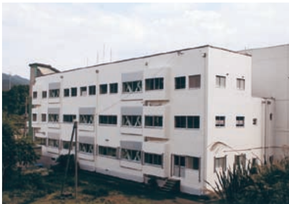
倉俣小学校耐震補強工事（平成20年度）
