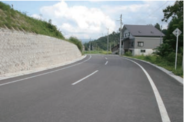
平成21年 1 月、樽沢本線の国道253号線から北沢川間の改良工事がしゅん工しました
