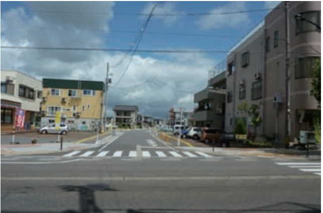
平成20年 6 月、十日町駅西土地画整理事業地内の市道高田町稲荷町線が開通しました
