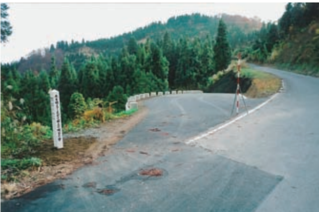
林道中魚沼丘陵南線(写真右)に接続した林道新屋敷線
