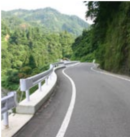
着実に進む道路整備
