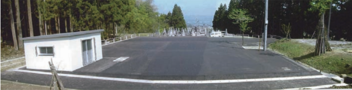
水沢中央地区簡易水道 高区配水池（細尾地内） 広場の地下に水槽を造り、315m 3 の水道水を貯留しています。
