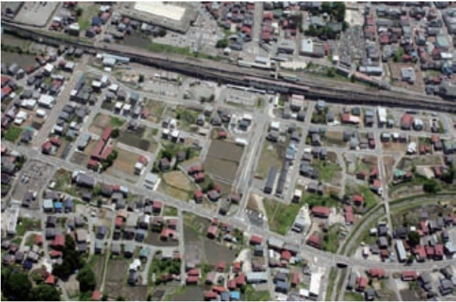
道路改良や宅地区画造成が進む駅西、西本町地区。
