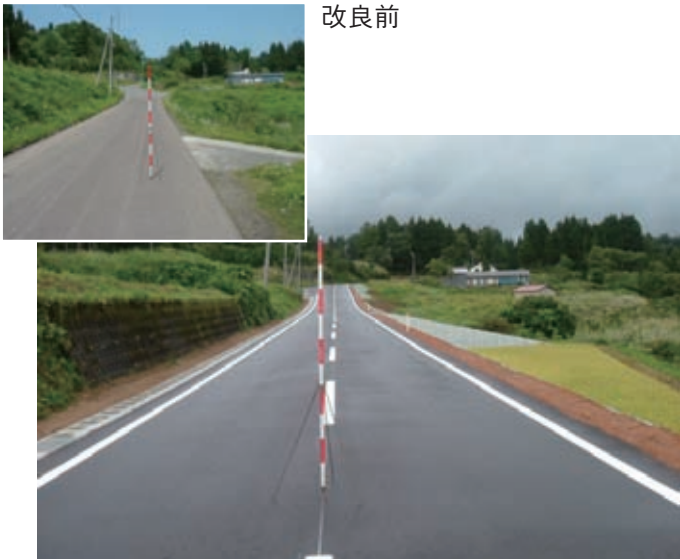
改良前 市営バスの安全な運行と効率的な除排雪を行うため、室野山平線（松代地域）を2車線化する拡幅改良工事を行いました。
