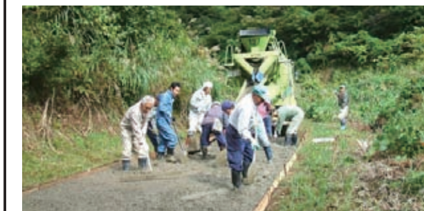
協力して林道の生コン舗装もこなしています
