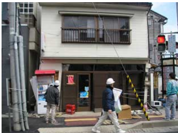
建物被害判定調査
