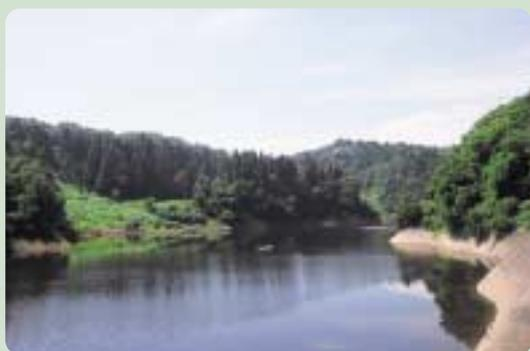
昭和52年に築堤が完成し、翌年53年には横綱北の湖関(当時)による地固め式が行われました。堤高43m、堤頂長170m、総貯水量122万 $m^3$ の川西ダムは、受益面積600haを賄う市内最大の農業用ダムです。
