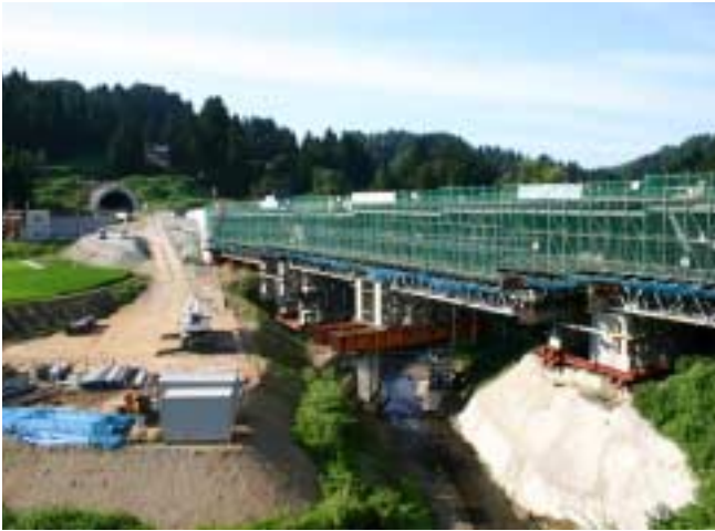
国道353号松之山バイパス高館トンネルの下鰐池側出口に架けられている新大橋。開通すると区間距離が1.6km短縮されるとともに勾配やカーブが解消され安全な交通体制が整備されます。
