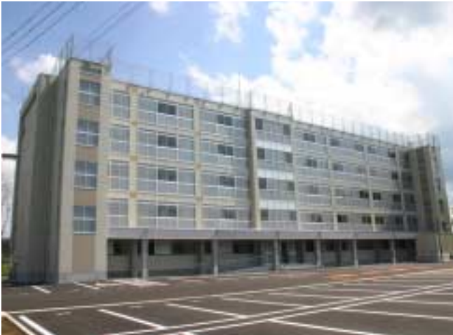
四日町新田地内に整備された市営住宅。鉄筋コンクリート造り5階建てで35戸が入居できます。
