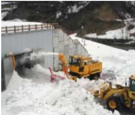
雪冷熱を利用した保管庫「雪室」への雪の吹き込み作業（仙田体験交流館キラリ）
