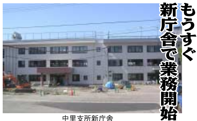
中里支所新庁舎
