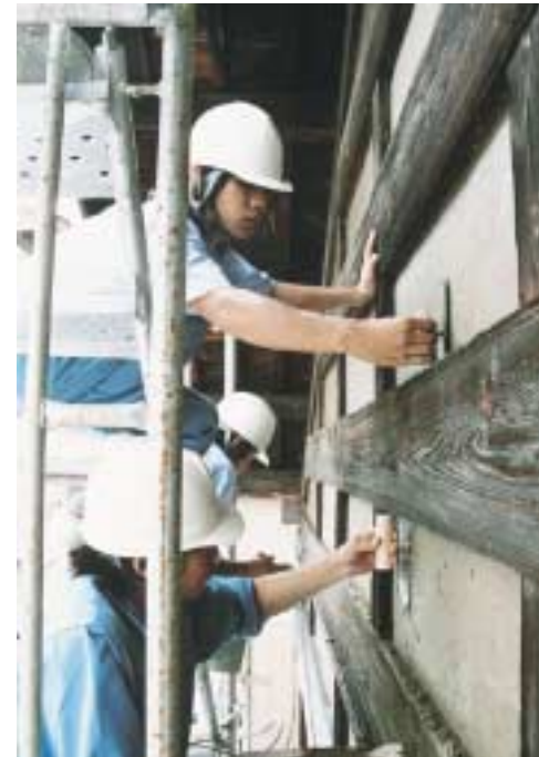
商店街の民家に土壁を仕上げる魚沼テクノスクールの生徒たち
