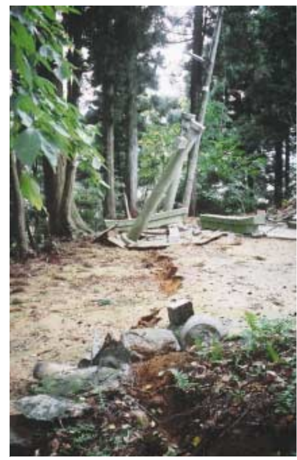
震災で倒壊した神社の鳥居（田川町1）
