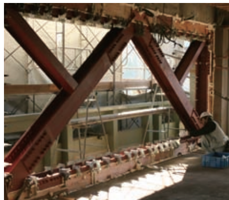
「鉄骨ブレース」が10か所入ります
