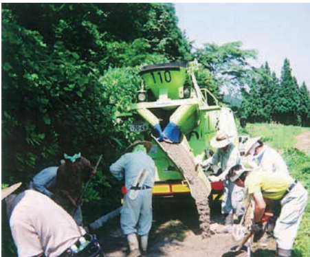
農道のコンクリート舗装 (笹之沢・池之平集落協定)
