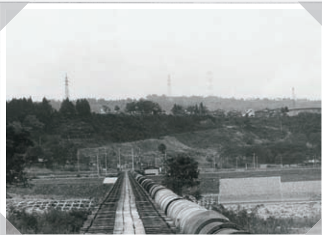
JR千手発電所軽便線鉄橋
