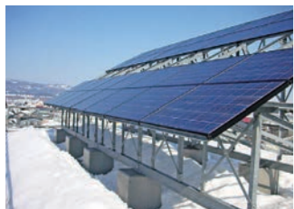
■住宅用太陽光発電システム設置費補助金制度／2010年度から住宅用太陽光発電システム設置費の補助を始めました。2012年度からは補助額を拡充し、全国トップクラスの助成で市民の自然エネルギー利用への取組みを支援しています。
