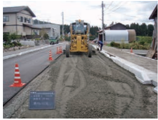
■道路・河川整備／地域活性化につながる地域高規格道路の建設をはじめ、毎日の暮らしを支える生活道路や河川の整備に努めています。
