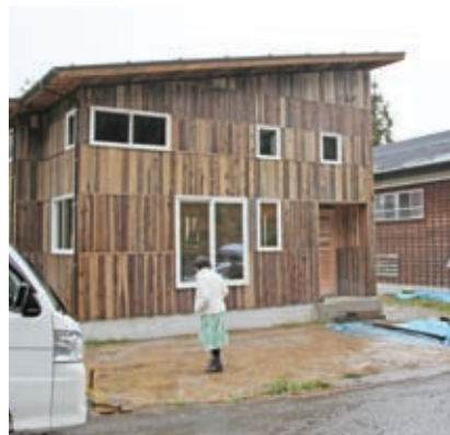
上▶7年目となる実行委員会主催の「田んぼへ行こう」の参加者との一枚。県外からの参加者と作業を通じて交流します。／下▶池谷地内に、来年春に完成予定の移住者向け住宅「めぶき」を建設中です。農業後継者を育てるための施設として利用されます。
