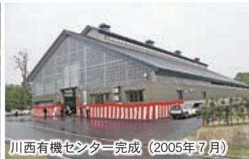
川西有機センター完成（2005年7月）
