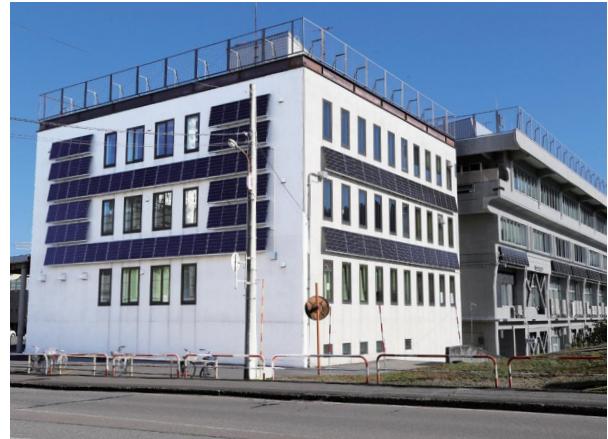
市役所本庁舎 太陽光パネル設置
