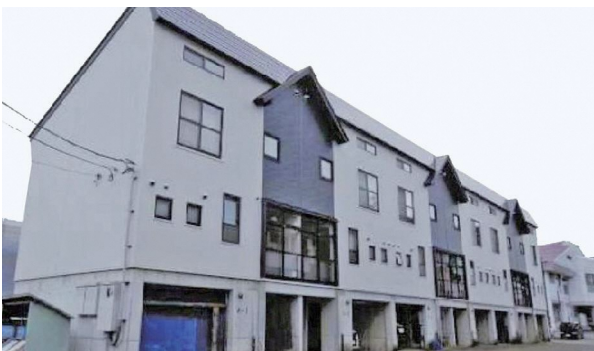
屋根や外壁の改修を行った「公営住宅」
