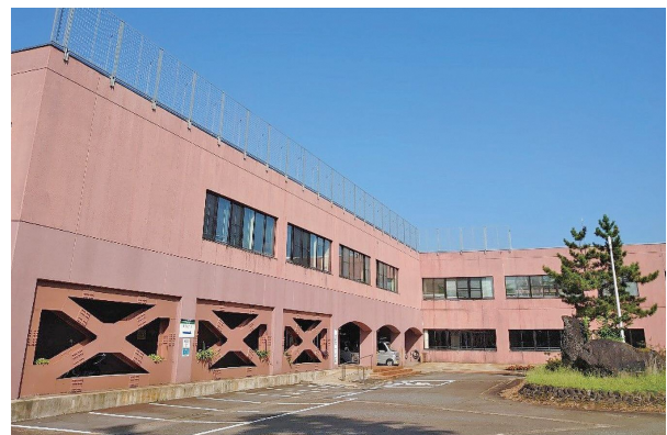
耐震化した十日町市下水処理センター（管理棟）
