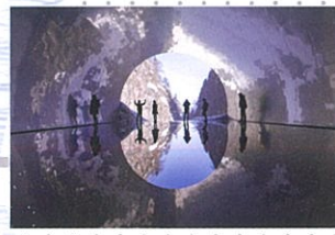
⑥ Tunnel of Light マ・ヤンソン/MADアーキテクト (清津峡渓谷トンネル)
