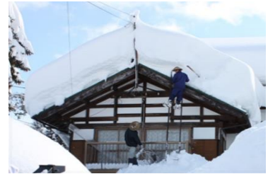
屋根雪を除く作業「雪堀り」
