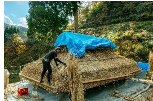
農舎を棚田の農業を紹介する施設として改修
