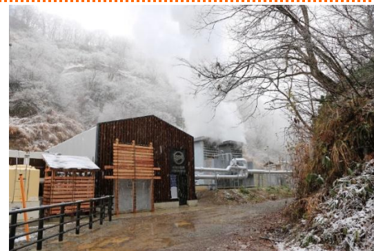
松之山温泉地熱バイナリー発電所
