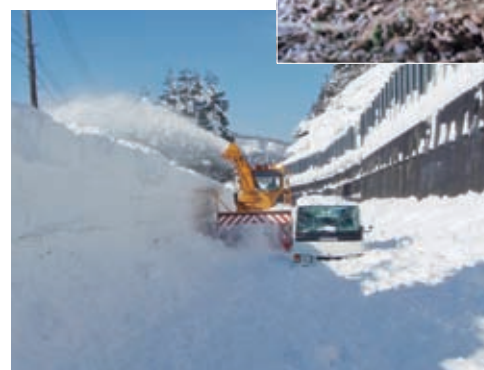
左：なだれが発生したときの除雪作業
