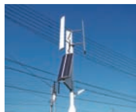
太陽光と風力発電のハイブリッド型街路灯発電
