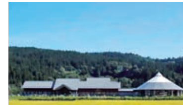
太陽光発電と木質ペレットボイラーを給湯などに活用
