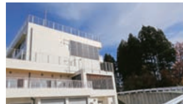
校舎壁面に太陽光発電を設置
