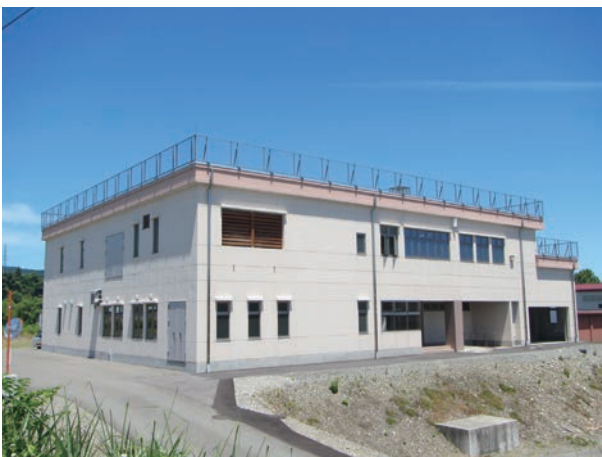
十日町浄水場（平成31年3月完成）
