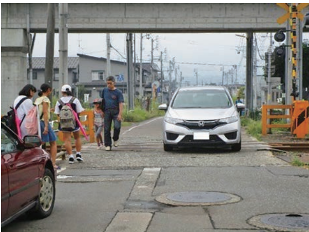
拡幅予定の稲荷町踏切
