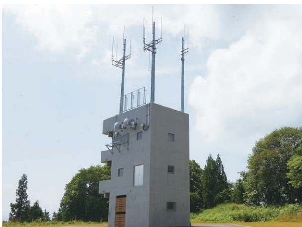
城山無線局舎（中里地域）
