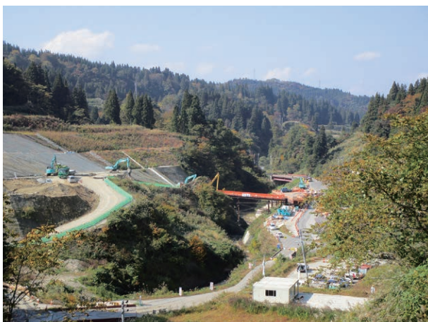
早期全線開通が望まれる八箇峠道路
