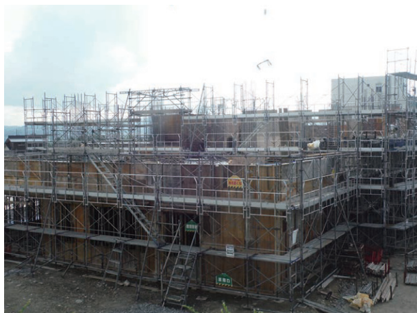
改築中の小学校
