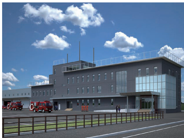
新消防本部庁舎
