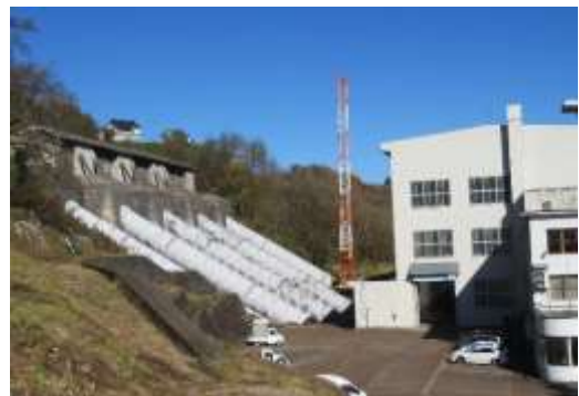
写真 2-4 : 千手水力発電所
