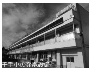
太陽光発電 蓄電池
