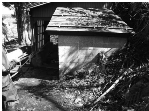
馬場小学校旧プール施設
