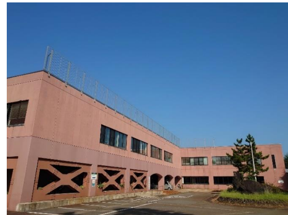
下水処理センター
