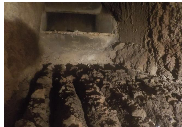
ごみ焼却2号炉内部 耐火物の状況
