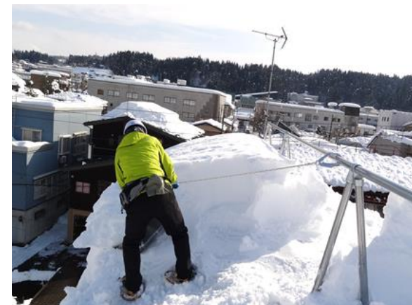
安全装置を活用した雪下ろし作業
