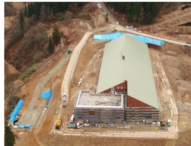
工事の進捗状況 (令和3年12月)
