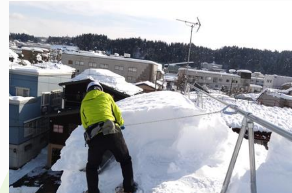
安全装置を活用した雪下ろし作業
