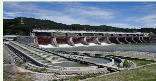
JR東日本信濃川発電所宮中取水ダム
