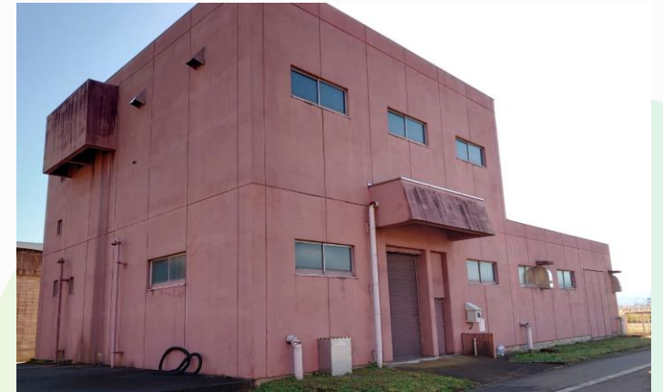
汚泥濃縮棟の外観
