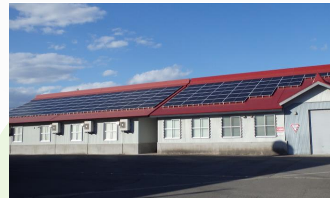
市内事業所への太陽光パネル設置
