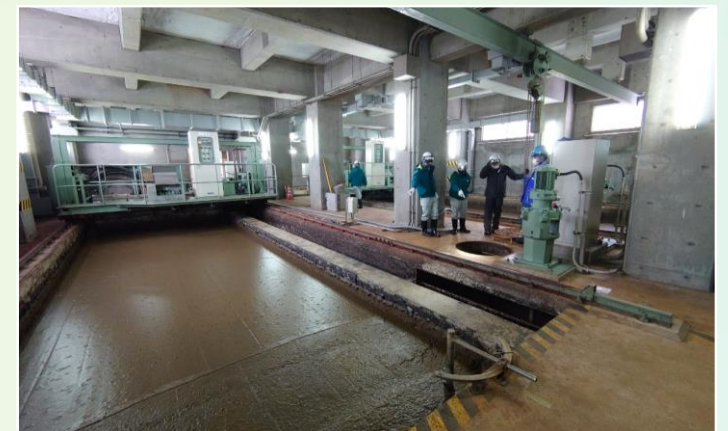
内部機器の状況
