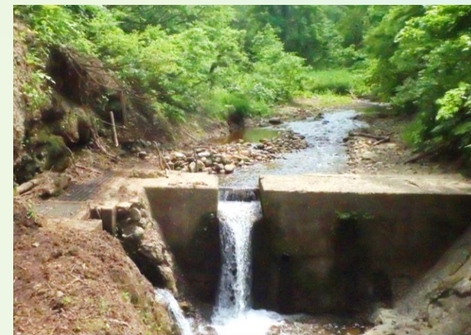
小水力発電検討箇所の取水口
