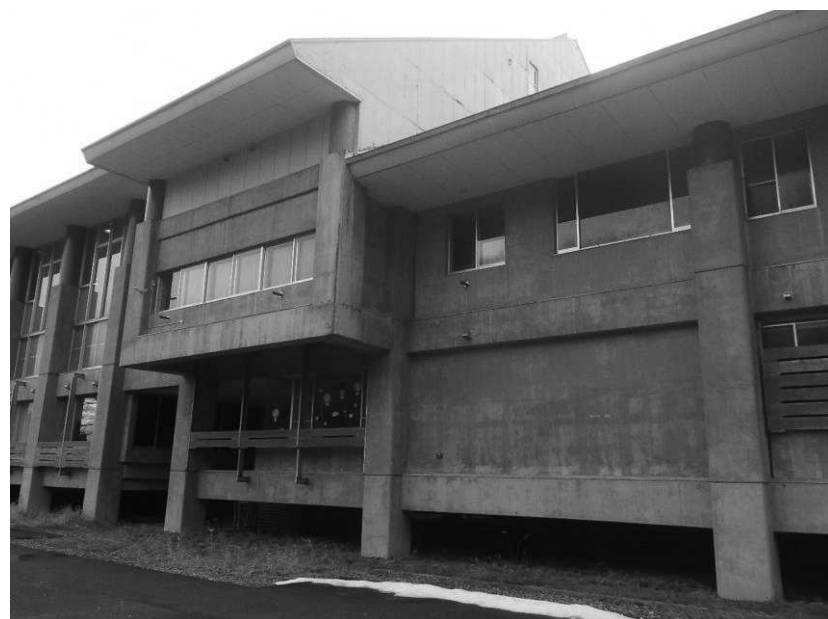
松之山小学校 屋内体育館
