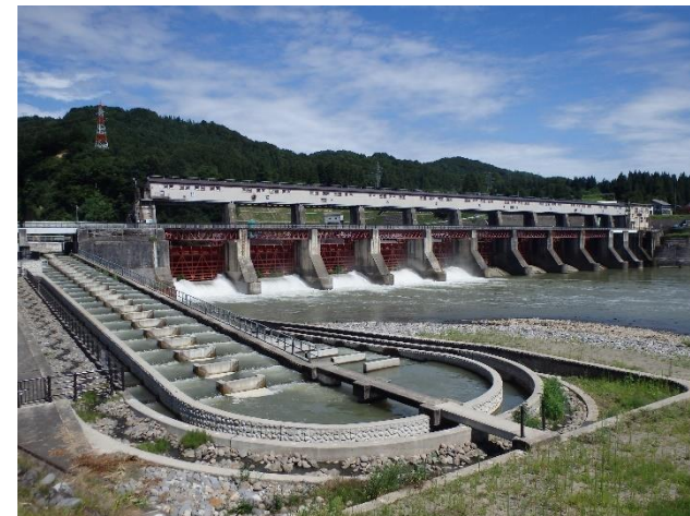
JR東日本信濃川発電所宮中取水ダム
