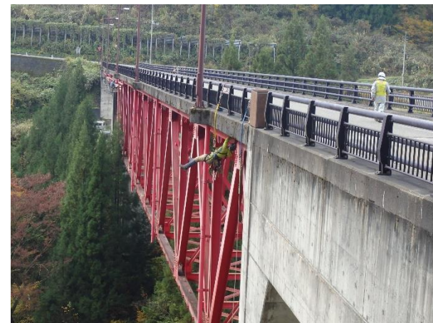
東川上鰯池線道路橋の橋梁点検
