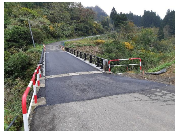
修繕した双倉橋（倉下土倉線）
