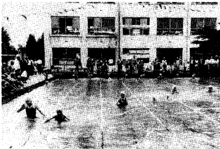
千手小学校プール
