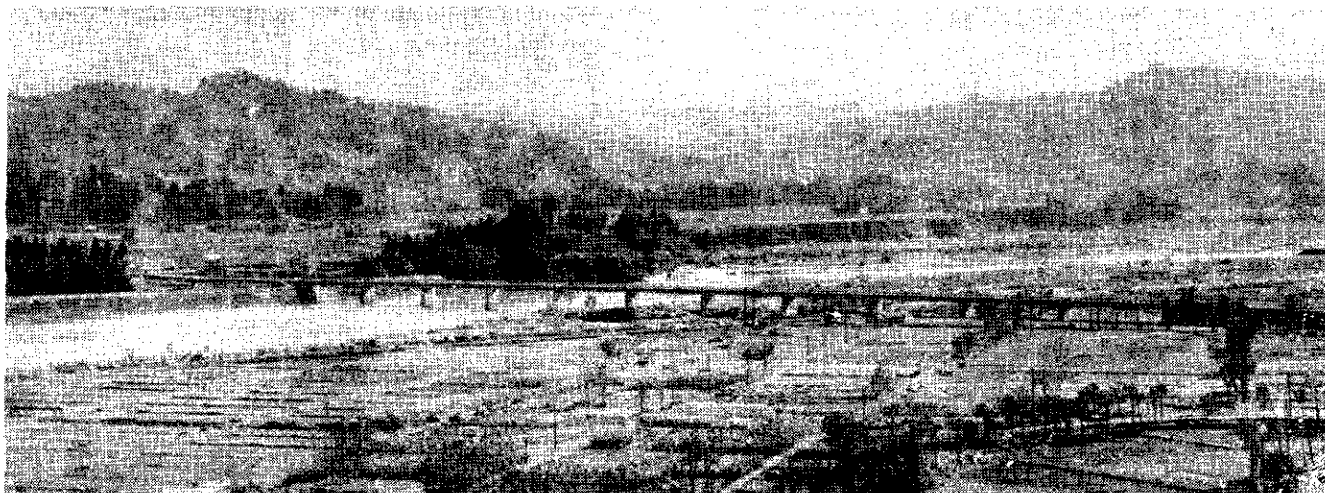
みごとに完成した栄橋の全景
