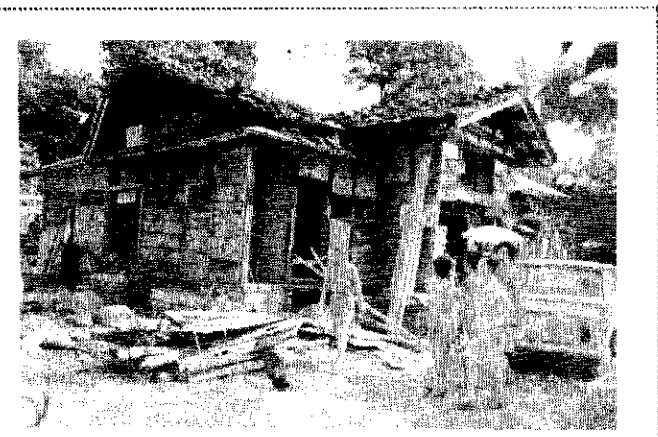
水洗トイレの先進地視察 先月24日、婦人会と衛生推進員の代表25人が、部落単位で水洗便所設置を進めている栃尾市山葵谷(わさびだに)を視察いたしました。
