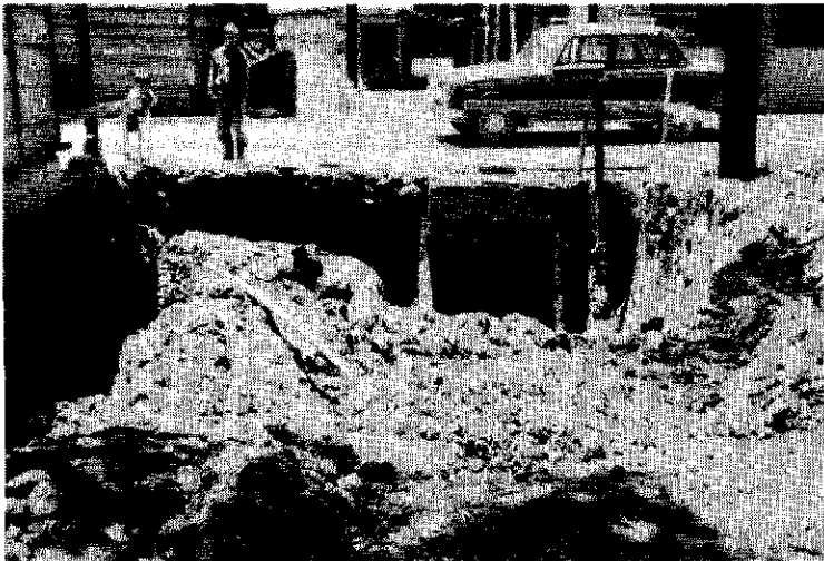
▲ 沖立防火水槽（掘削）
