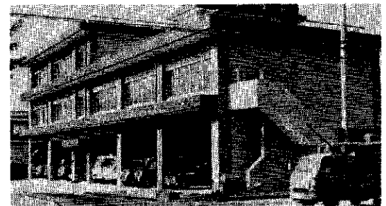
完成した消防庁舎
