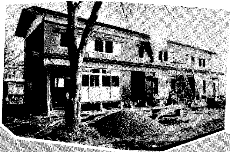
▶ 教員住宅 順調に工事が進む 教育センター ▼
