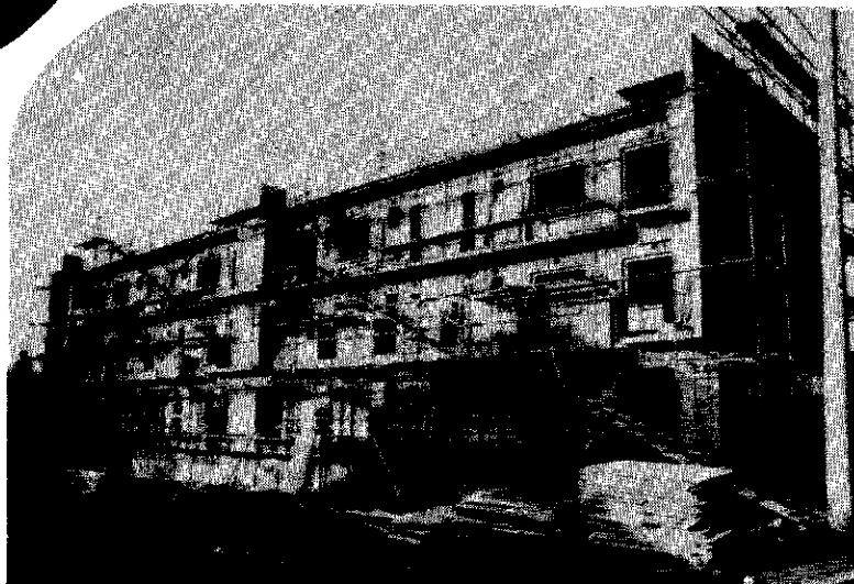
鉄筋三階建ての教育住宅 一万平方メートルの宅地造成、住宅 建築もまもなく。
