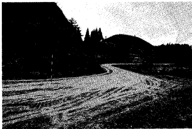
▲高倉から若ノ窪まで完成の林道
