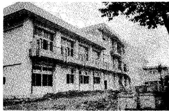
▲ クリーム色の外壁もあざやかにまもなく完成の千手小学校舎
