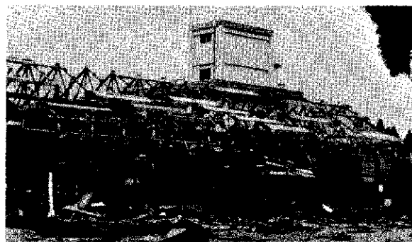
▲取りこわし中の千手小屋体
